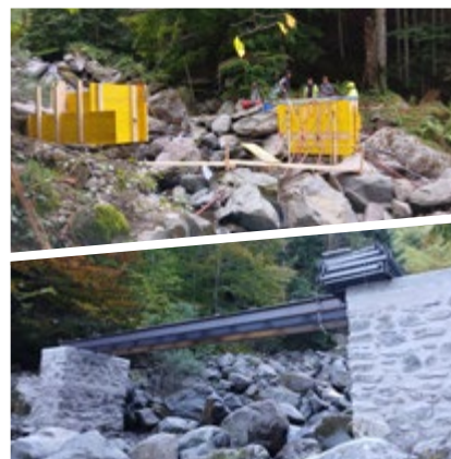
Passerelle d'Arnousse avant/ après
