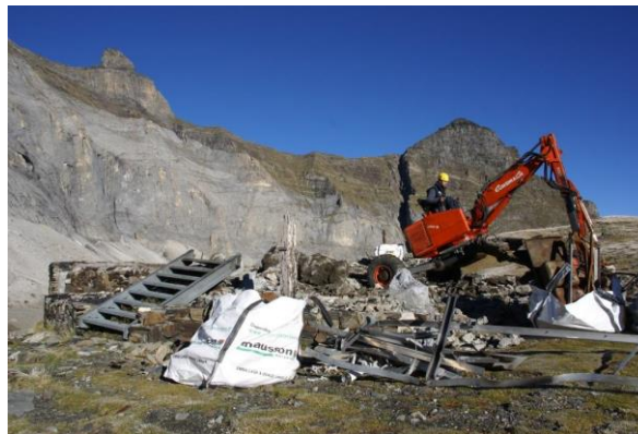
Evacuation des débris du refuge de Barroude © J. Le Souder - PNP
