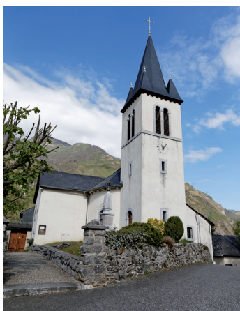
Eglise de Louvie-Soubiron / © C. Cuenin- Parc national des Pyrénées
